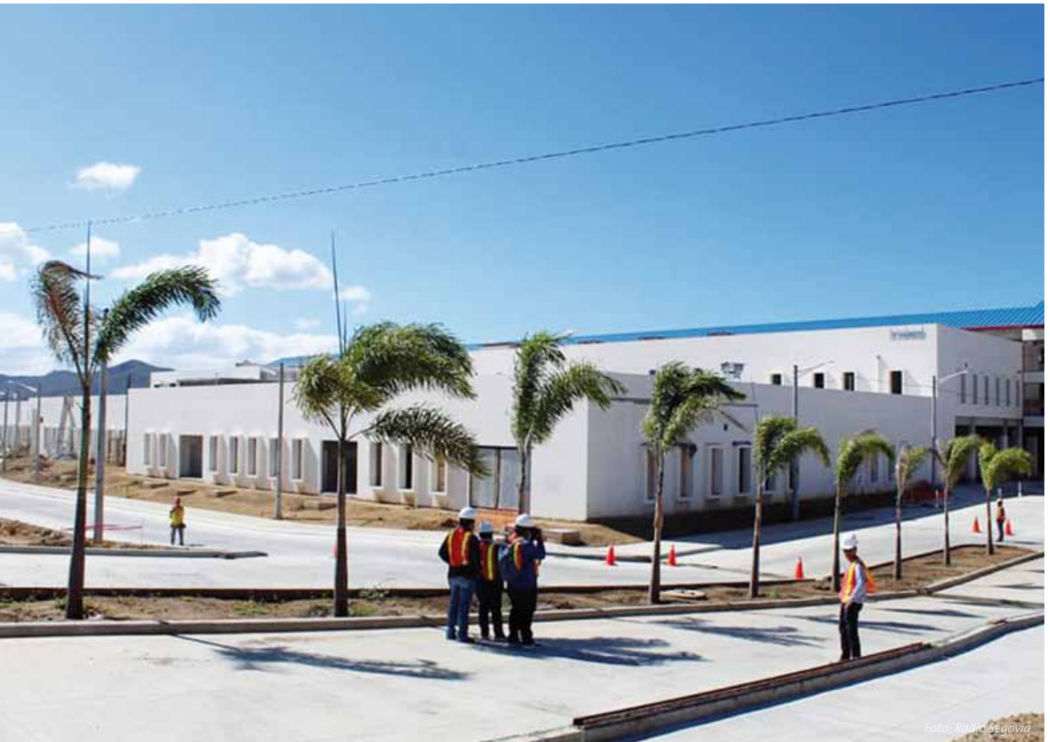
Der Bau des Krankenhauses schreitet voran
